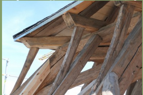
Holz: ein 270 Jahre alter Dachstuhl
