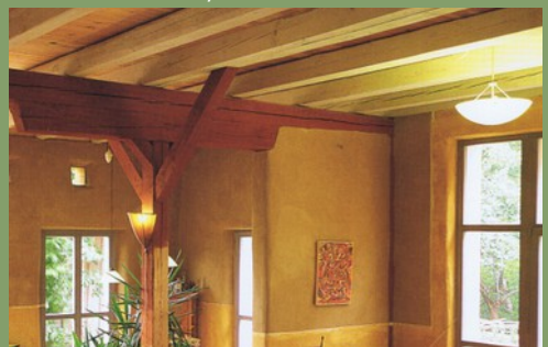
Lehm: Baustoff und gleichzeitig Deko im Wohnraum einer zum Wohnhaus umgebauten Scheune
