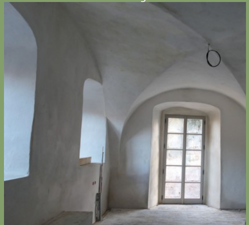
Kalk: Verputzt und Anstrich mit reinem Sumpfkalk
